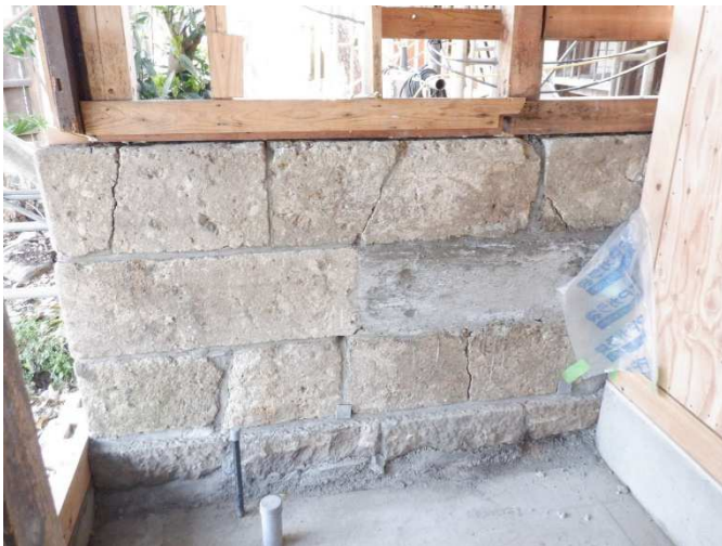
【店】石積み基礎復旧
