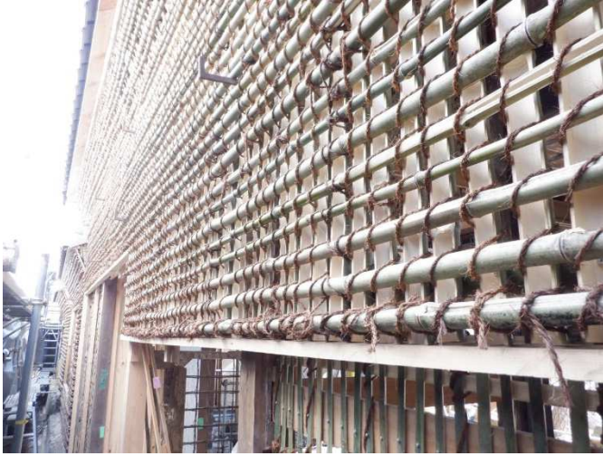
【座敷】北側外壁竹小舞施工
