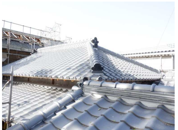
【座敷】屋根瓦施工
