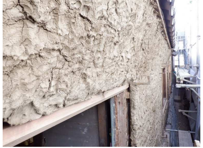
【座敷】北側外壁荒壁施工
