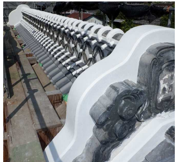
【ミセ座敷】屋根大棟飾り漆喰施工
