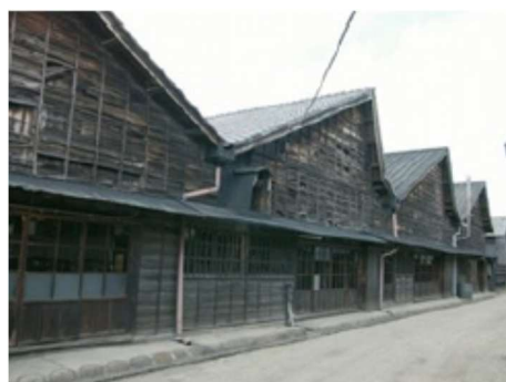
日本遺産「かかあ天下ーぐんまの絹物語ー」 構成文化財の1件(ノコギリ屋根工場)
