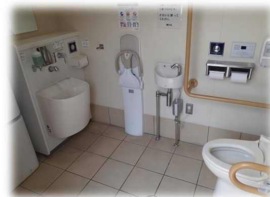
上電西桐生駅前公衆トイレ（多目的トイレ）
