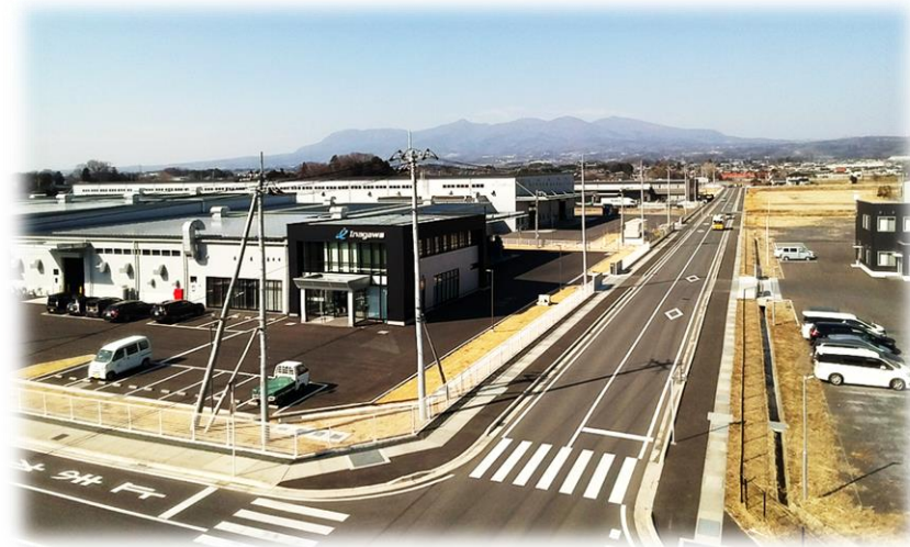
桐生武井西工業団地
