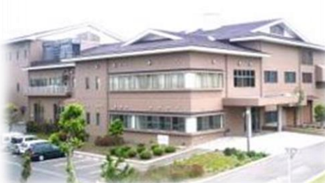
境野水処理センター（し尿処理施設）
