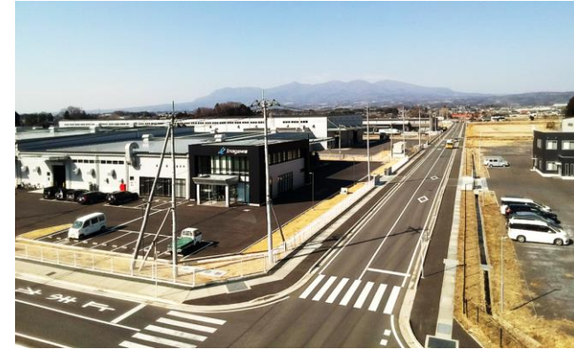
桐生武井西工業団地
