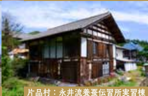
片品村：永井流養蚕伝習所実習棟
