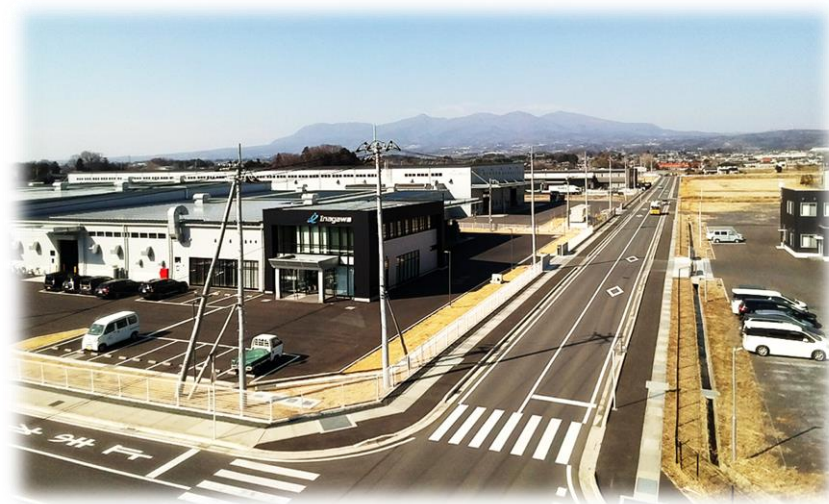
桐生武井西工業団地
