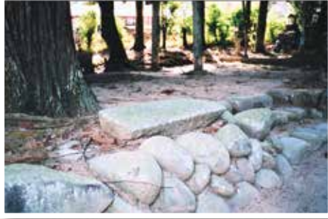
▲石橋の一部。同様の板石3枚で石橋とした。
