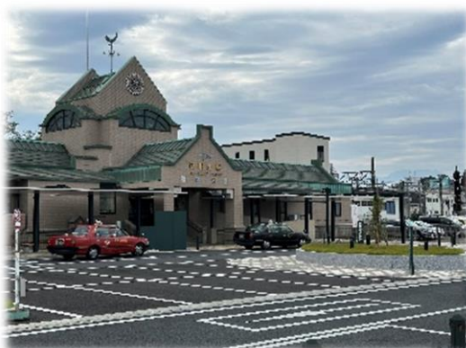
令和 4 年 3 月に整備された 新桐生駅前広場
