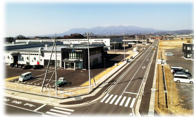
桐生武井西工業団地（新里町）
