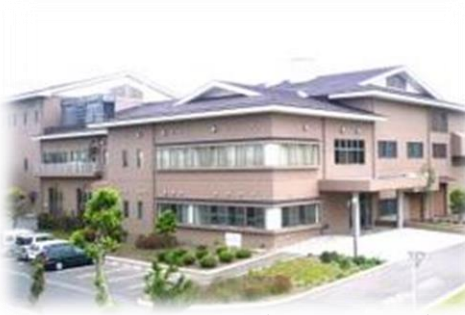
境野水処理センター（し尿処理施設）
