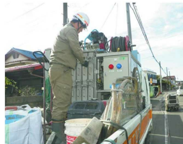
汚泥排水の現場処理風景
