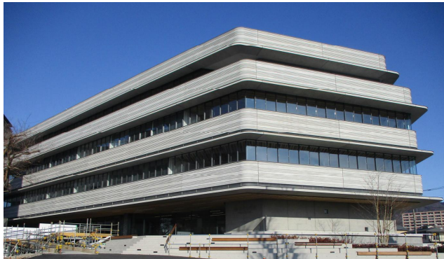
建設中の新庁舎南側外観 ↑
