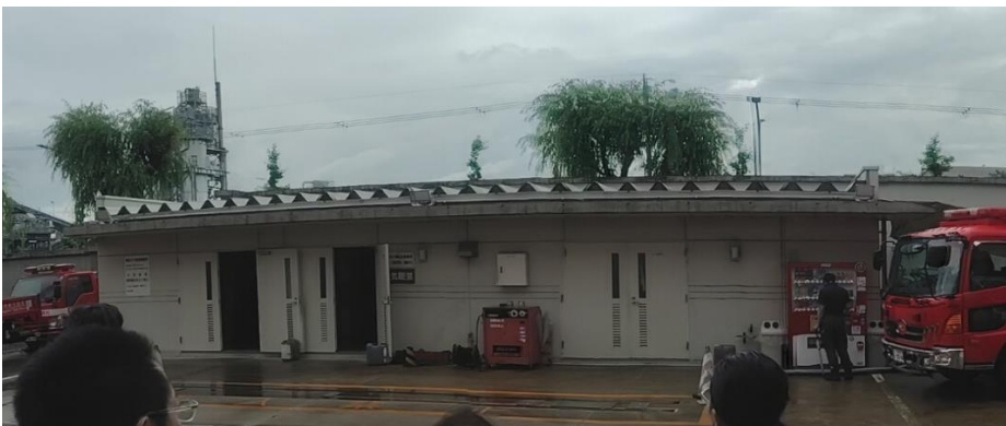
高圧ガス充填室(左側) 空気ボンベ、酸素ボンベを充填
