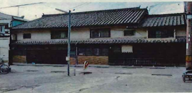
Cタイプ町家 (タイル・石貼の腰壁を持つ形式)
