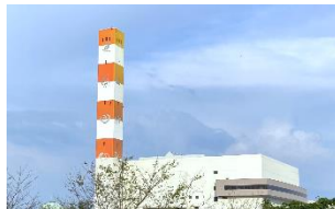
焼却：六供清掃工場
